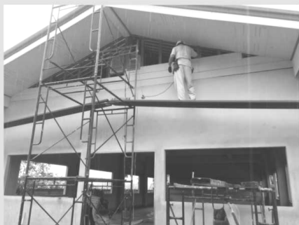
教學樓主建物已完成
